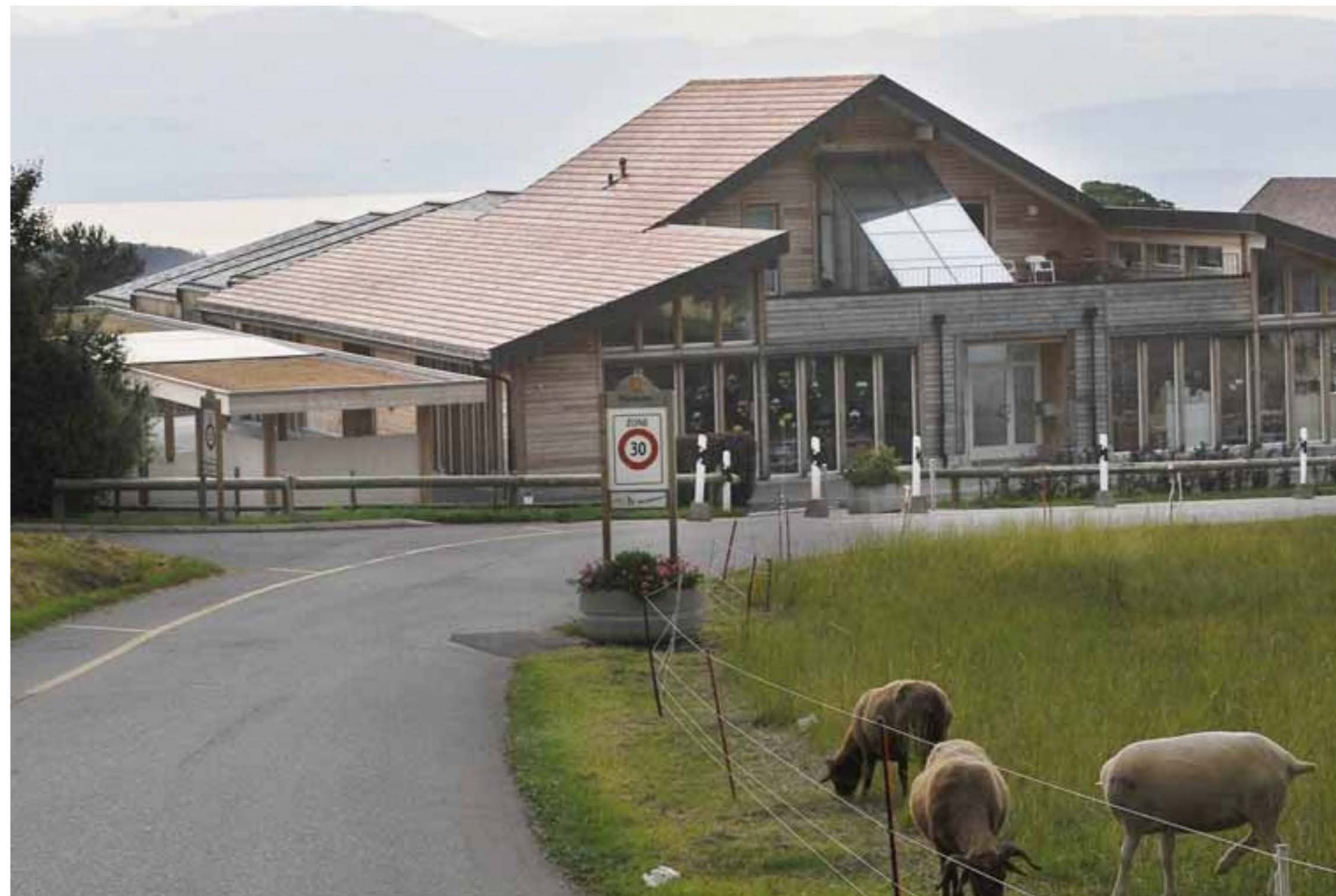
La commune de Bassins va transformer le préau couvert en salle de classe. Le Conseil communal a donné son feu vert à une demande de crédit extrabudgétaire de 360 000 francs à cette fin. TATIANA HUF
